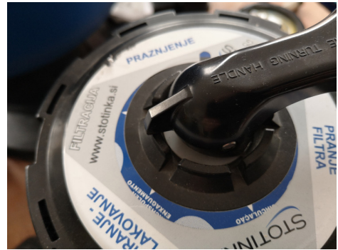
ventil v nevtralni poziciji
